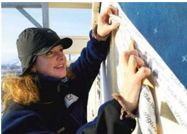
TETTER. Tømrer Kristin Håkerud arbeider med diffusjonsåpen tetting mellom tak og vegg.
